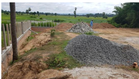
Het community huis heeft een vertraging opgelopen. Door zware regenval was het zand weggezakt. D.m.v. het plaatsen van een stevige muur constructie is dat nu verholpen en.... De bouw kan beginnen.
