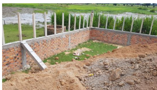
Het community huis heeft een vertraging opgelopen. Door zware regenval was het zand weggezakt. D.m.v. het plaatsen van een stevige muur constructie is dat nu verholpen en.... De bouw kan beginnen.
